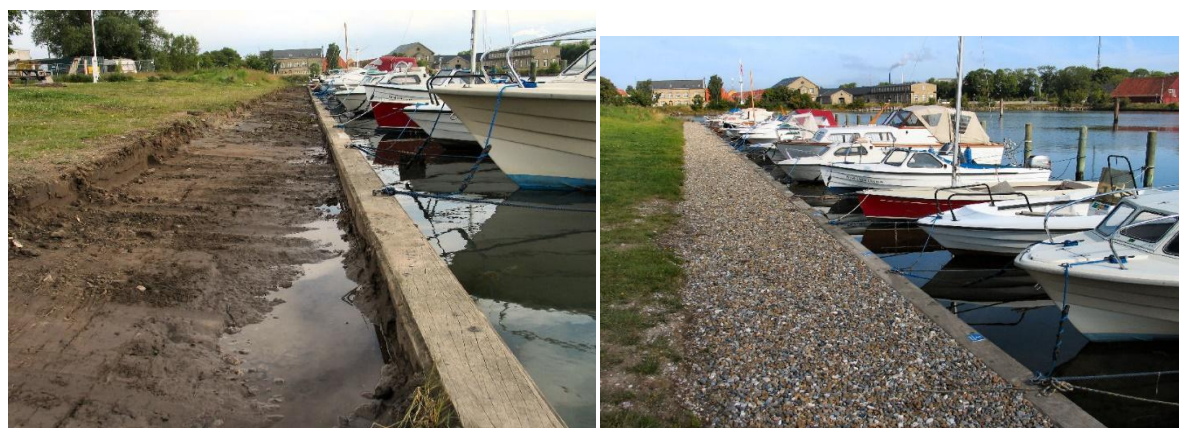
Arealet ud mod bolværket graves af inden de flotte perlesten lægges ned i stedet.
